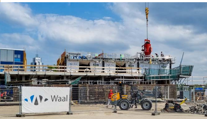
De tunnels zijn inmiddels in volle gang.
